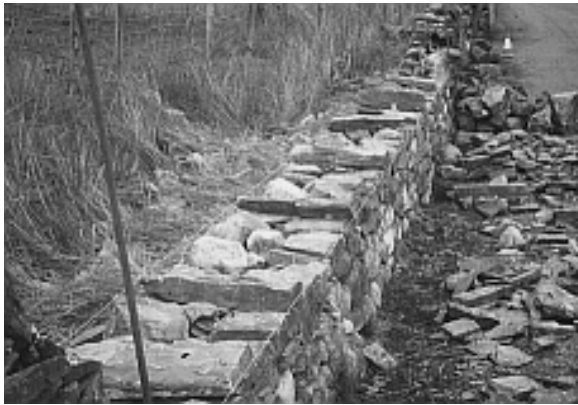
Flush throughs, Mynydd Llandegai, Bangor
